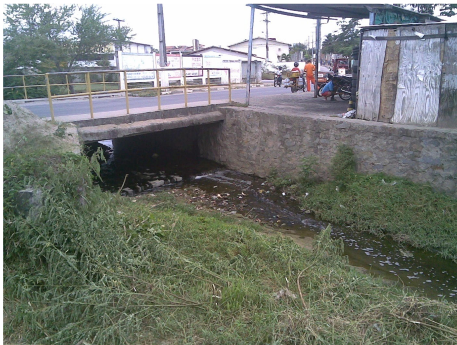
Figura 24 - Condições estético-sanitárias nas proximidades do Ponto 07
