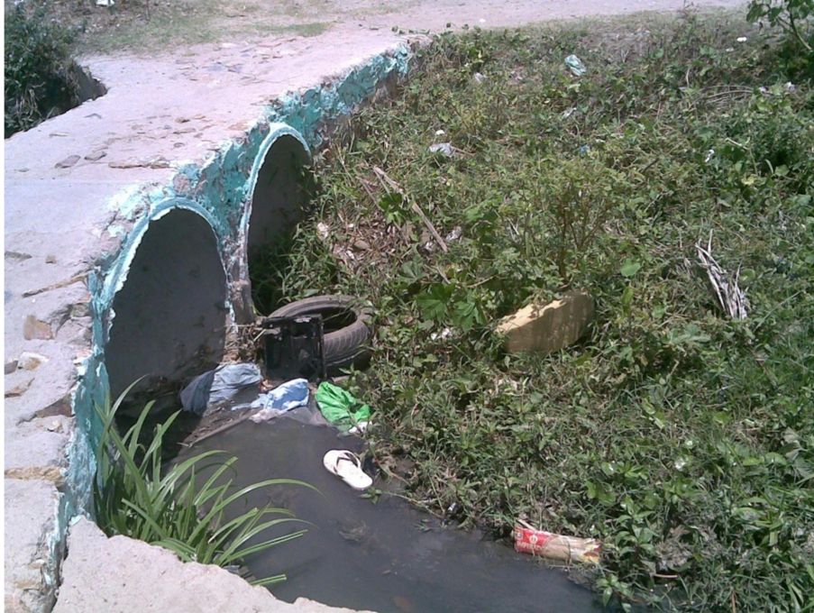
Figura 22 - Condições estético-sanitárias nas proximidades do ponto 05
