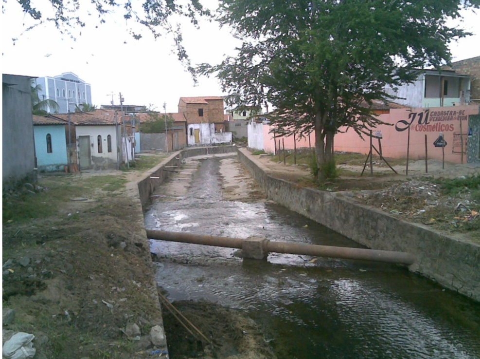
Figura 25 - Condições estético-sanitárias nas proximidades do ponto 08
