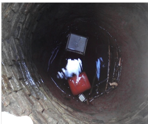
Figura 6: Poço da Residência no CIFS. Fonte: Foto do autor (2011).
