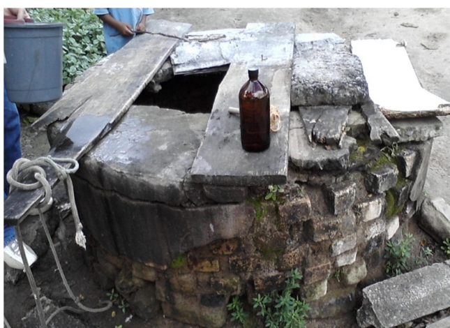
Figura 8: Área externa do Poço. Fonte: Foto do autor (2011).
