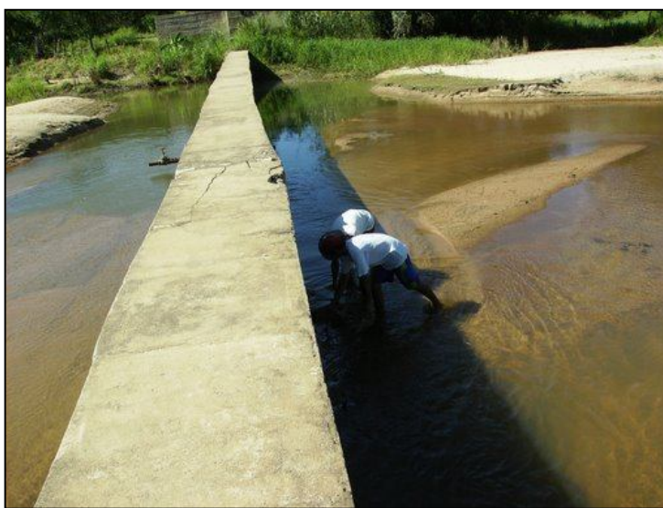
Figura 15: Foto de Barragem sucessiva. Fonte: www.imagensgoogle.com.br
