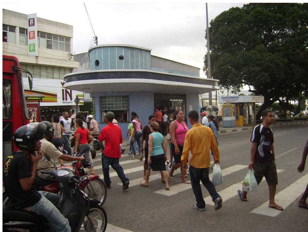
Foto 56. Abrigo na Praça da Bandeira, Avenida Getúlio Vargas.
