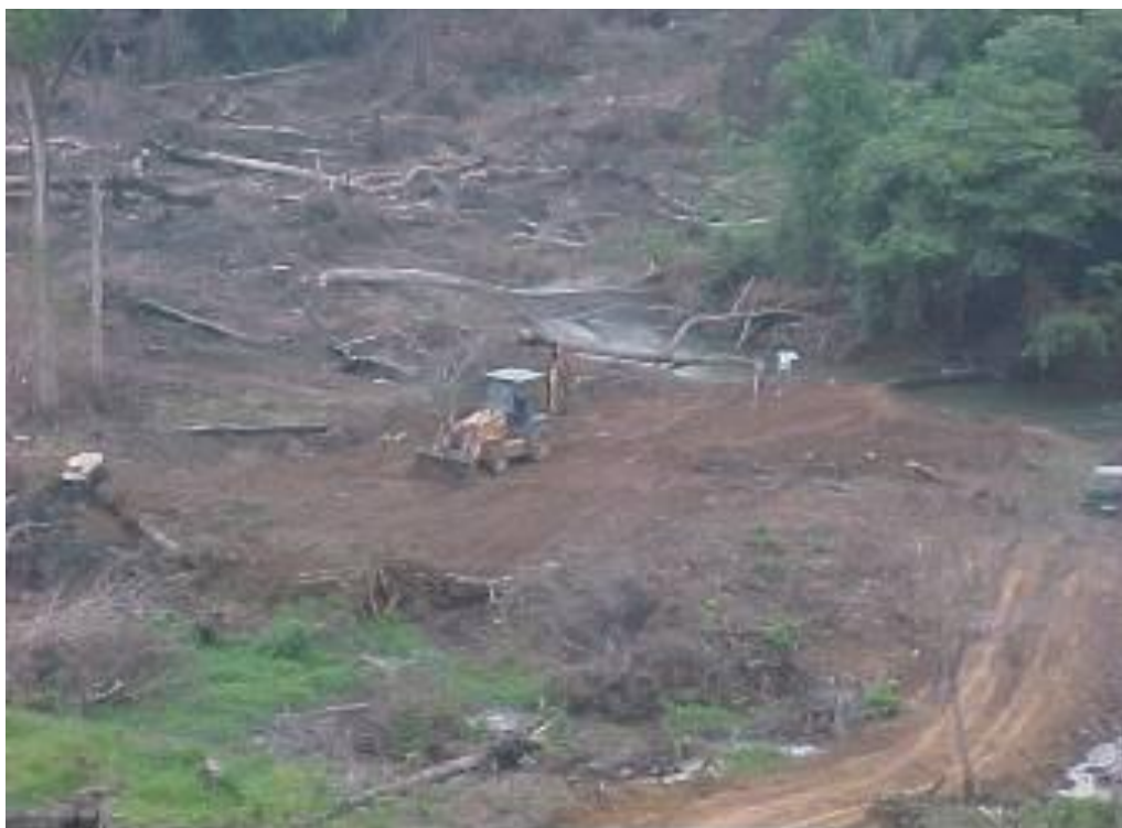
Figura 14 – Preparação do terreno para instalação de novas indústrias.
