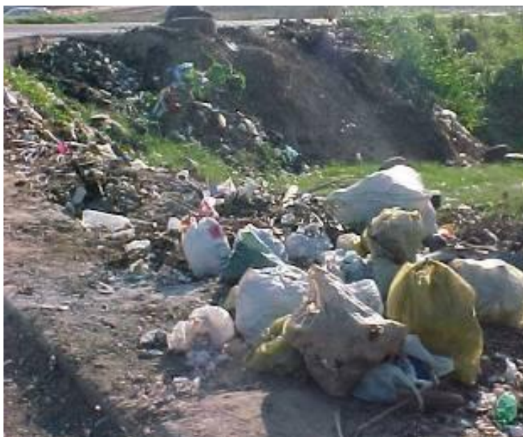
Figura 26 – Presença de resíduos acumulados nas margens da represa Ipitanga III. Fonte: Inspeção de campo
