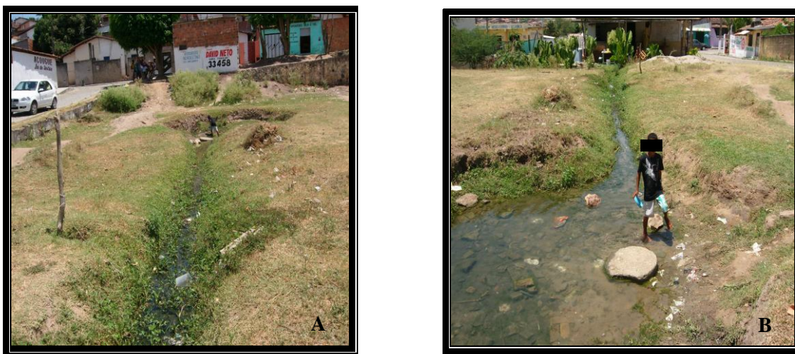
FIGURA 15. A - Canal de drenagem em precárias condições na localidade do Homero Figueiredo. B - Criança descalça em águas contaminadas na localidade Homero Figueiredo.
