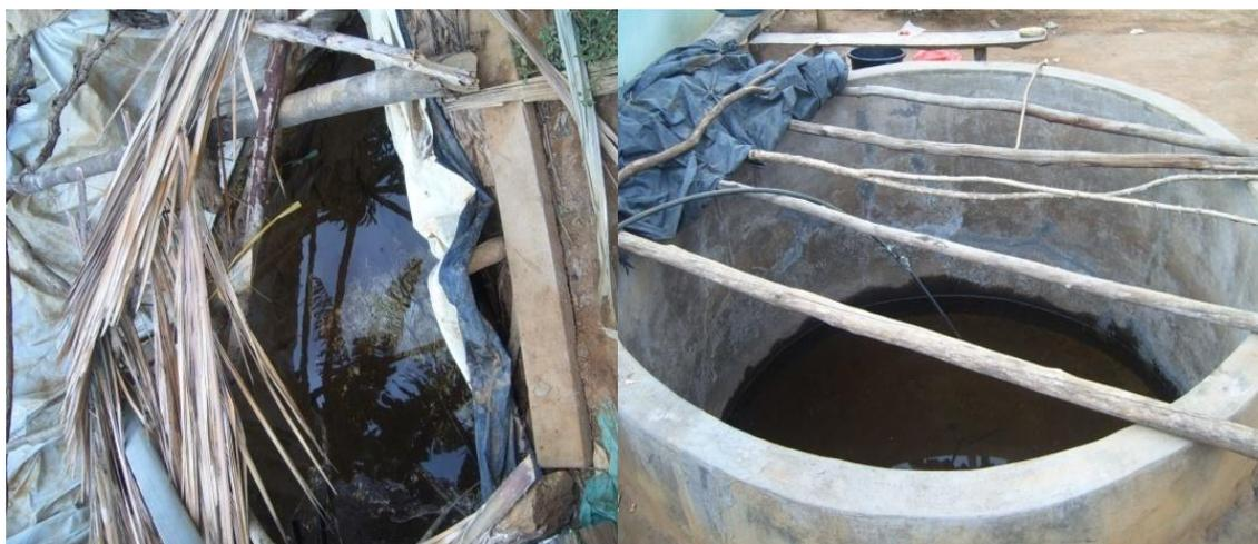
**Figura 20** Soluções alternativas da população à falta de abastecimento de água: Tanque cavado no chão, revestido com lona plástica e coberto com palha e Tanque construído ao lado da residência descoberto (sem tampa).
