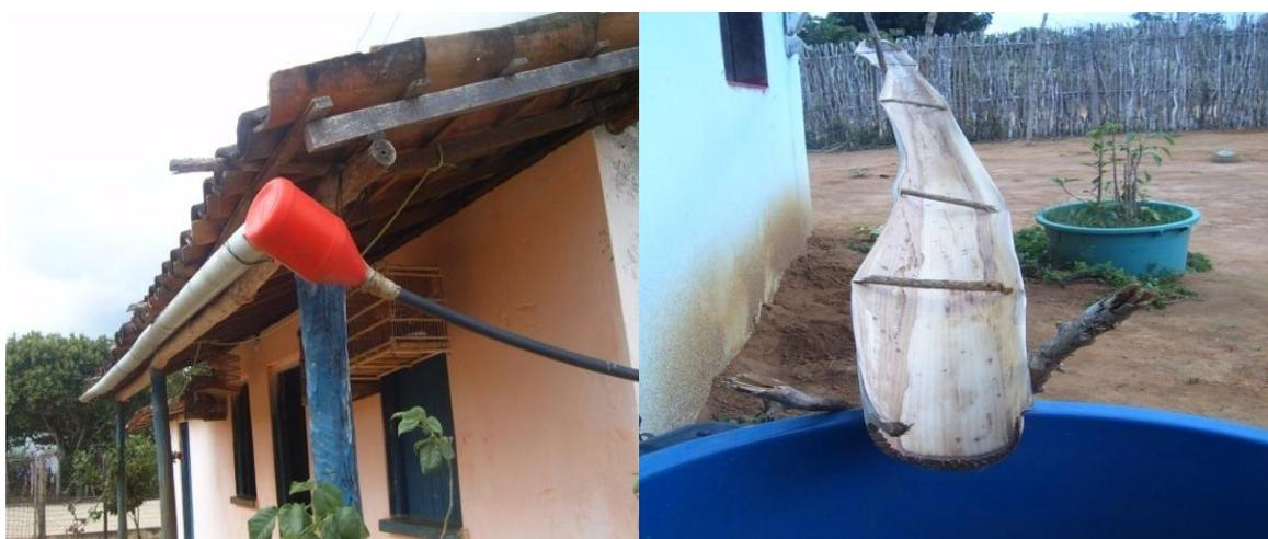
**Figura 19** Soluções alternativas da população à falta de abastecimento de água: Vasilhame plástico e Caule de bananeira reutilizado como calha para captação de água da chuva.
