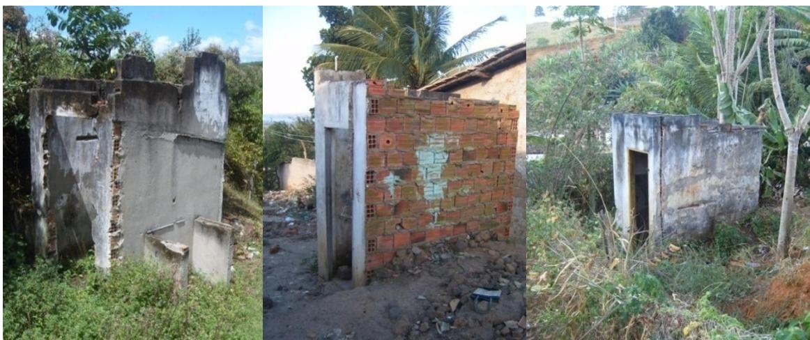
**Figura 14** Instalações Sanitárias realizadas pelos Programas de Melhoria Sanitária (MSD), destruídos ou abandonados, em comunidades dos municípios baianos A, B e C respectivamente.
