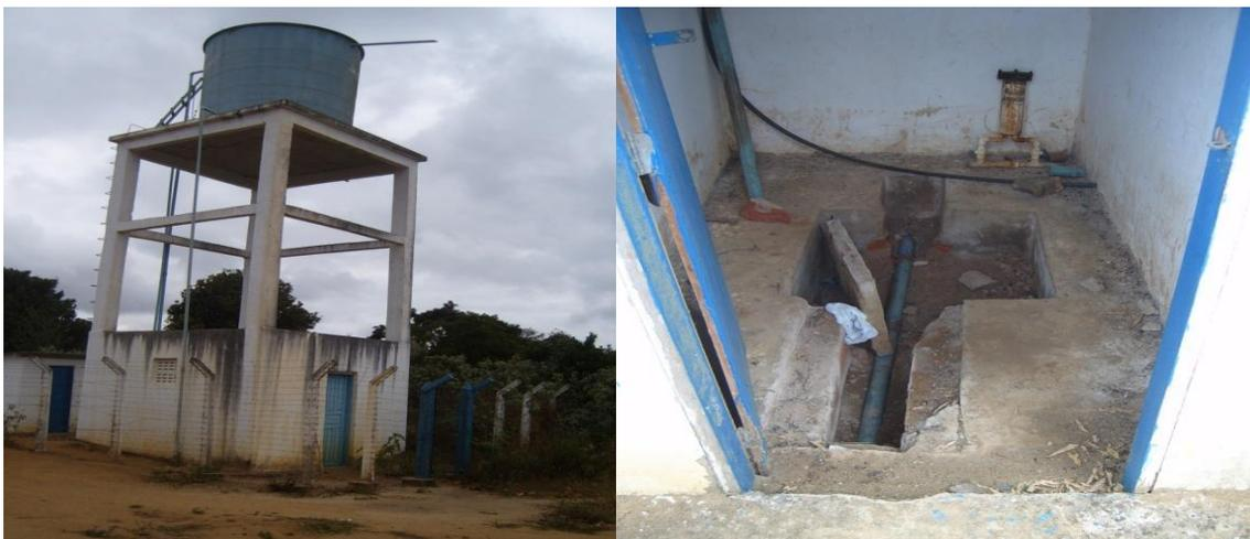
**Figura 16** Condições do Sistema de Abastecimento de Água implantado pelo Programa, tanque elevado para armazenamento e distribuição de água e Casa de Tratamento de água sem clorador, em uma comunidade do município baiano D.
