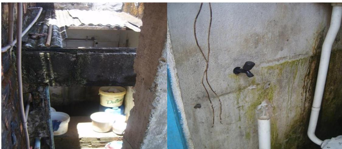
**Figura 11** Estado de conservação das Instalações Sanitárias realizadas pelos Programas de Melhoria Sanitária (MSD), com telhas de amianto quebradas, (município A) e nos municípios A,B e C, em alguns casos sem Pia plástica.
