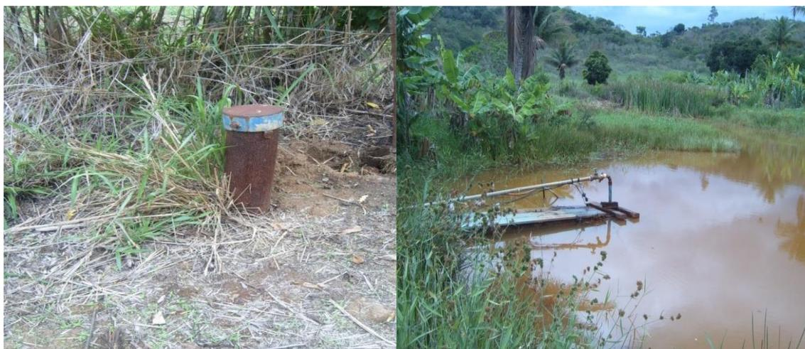
**Figura 15** Estado de conservação das Instalações do Sistema de Abastecimento de Água (SAA) com Poço perfurado inativo destruído e lagoa de captação de água.
