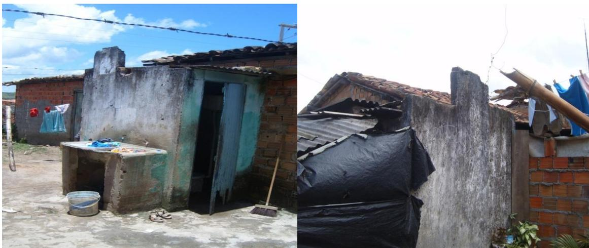
**Figura 10** Estado de conservação das Instalações Sanitárias realizadas pelos Programas de Melhoria Sanitária (MSD), sem tanque utilizado e com a pia para lavar roupa ( município A).
