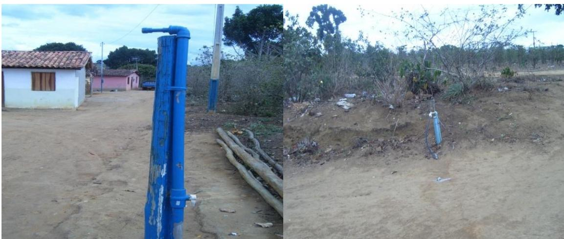
**Figura 18** Condições do Sistema de Abastecimento de Água implantado pelo Programa da Funasa, chafariz inativo e torneira exposta em estrada, em uma comunidade do município baiano D.
