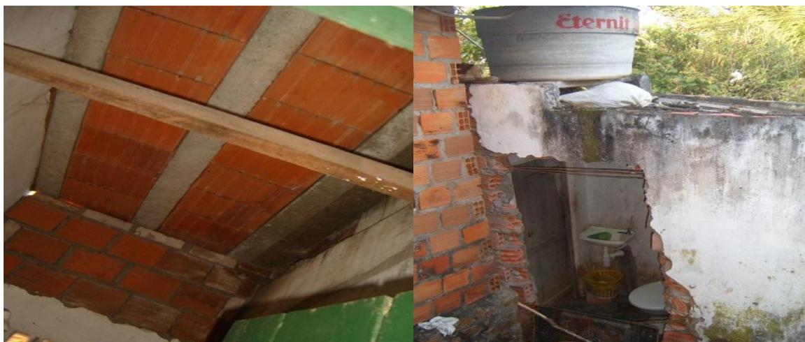
**Figura 08** Instalações Sanitárias realizadas pelos Programas de Melhoria Sanitária (MSD) com modificação para alteração da laje do tanque (município B) e para alterar a posição da porta (município B).
