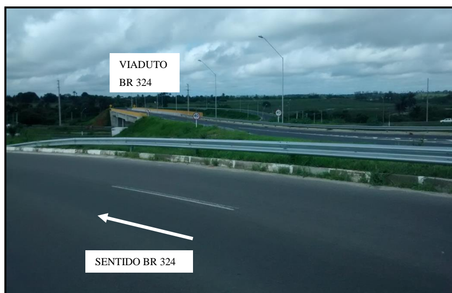
Figura 4. 3: Viaduto BR 324, avenida Nóide Cerqueira, Feira de Santana, 2018
