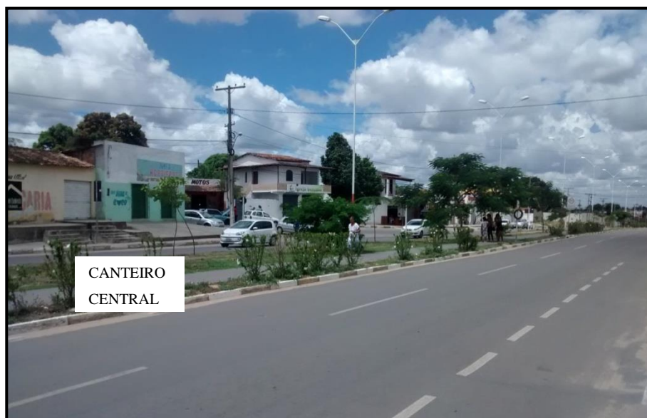
Figura 3. 27: Vias e canteiro, avenida Ayrton Senna, Feira de Santana, 2018
