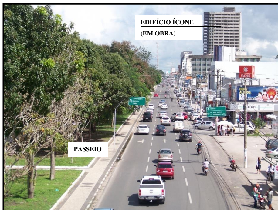
Figura 3. 11: Vista do viaduto, avenida Getúlio Vargas, Feira de Santana, 2014
