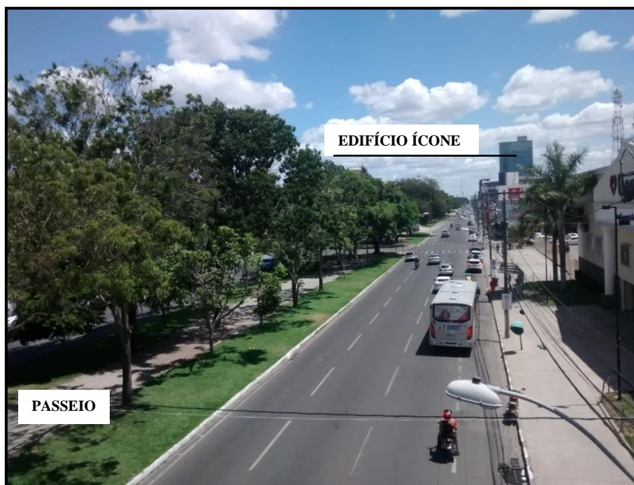
Figura 3. 12: Vista do viaduto, avenida Getúlio Vargas, Feira de Santana, 2018
