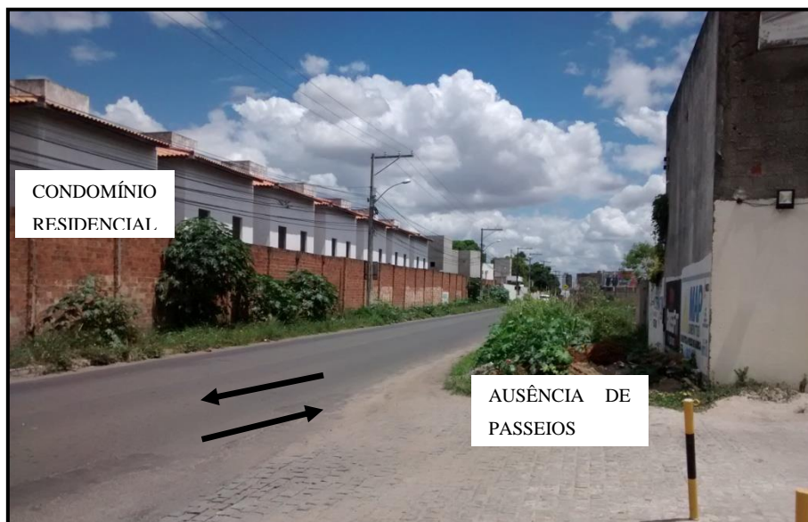
Figura 3. 50: Ausência de passeios, avenida Artêmia Pires, Feira de Santana, 2018
