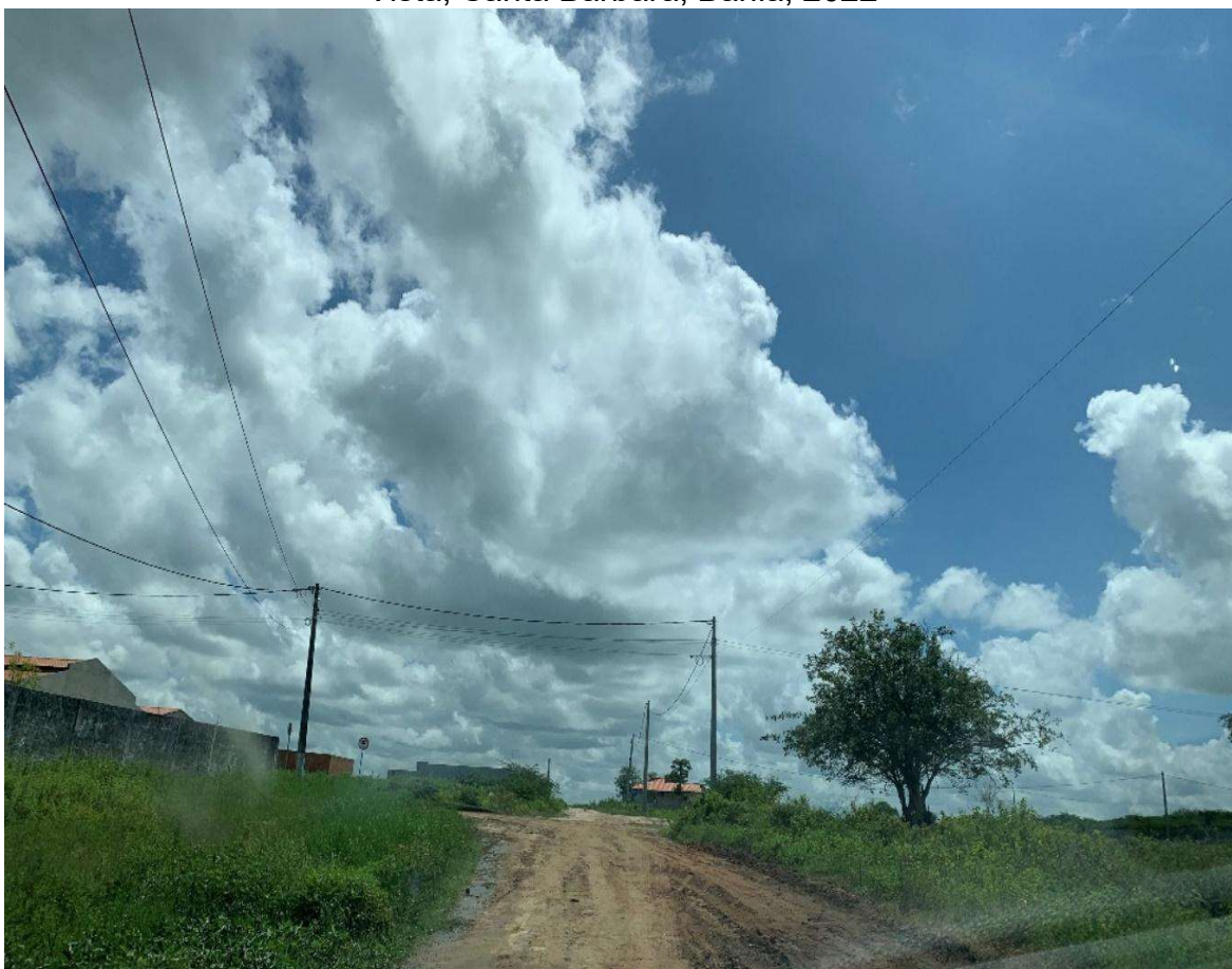
Foto 3 - Vias de acesso e infraestrutura do Loteamento Residencial Alto da Boa Vista, Santa Bárbara, Bahia, 2022
