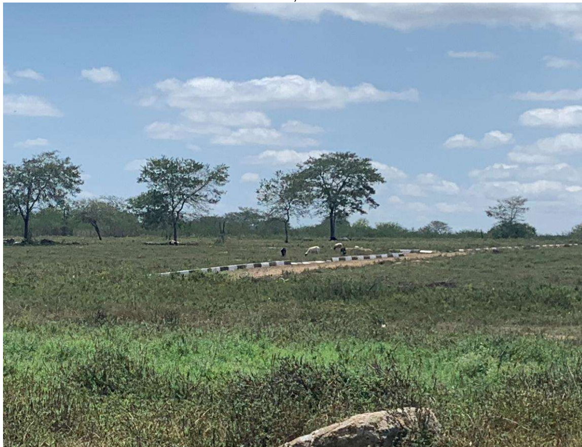
Foto 7 - Loteamento popular Bella Vista e infraestrutura instalada, Santa Bárbara, Bahia, 2022
