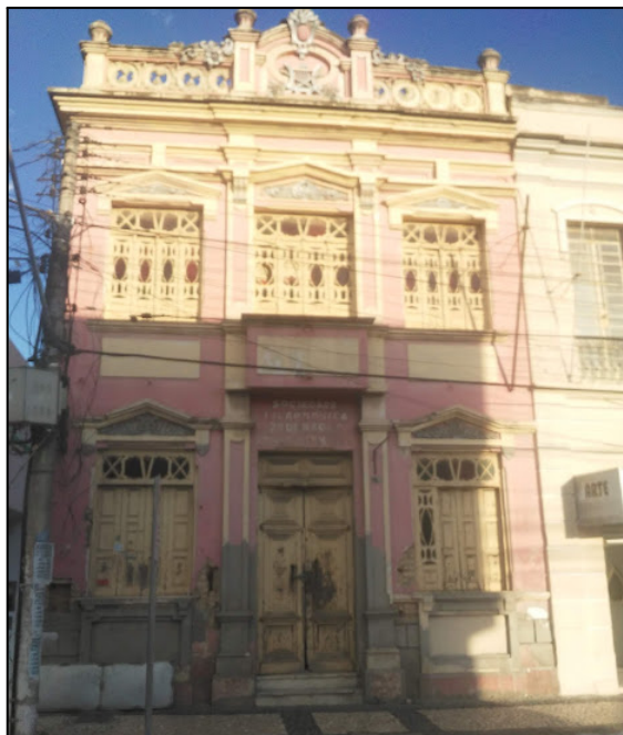
Foto 1 - Prédio Filarmônica 25 de Março.
