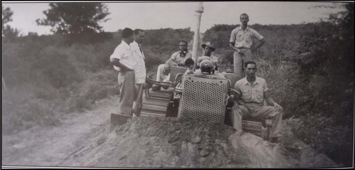
Foto 9 – Estrada de rodagem Maria Quitéria/Tanquinho, construída pela Prefeitura de Feira de Santana com trator particular da fazenda do então prefeito Aguinaldo Soares Boaventura. 16 de maio de 1950
