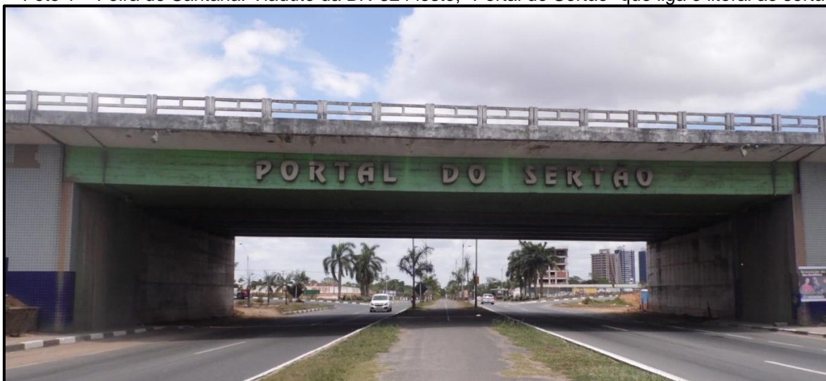
Foto 1 – Feira de Santana: Viaduto da BR-324 leste, "Portal do Sertão" que liga o litoral ao sertão
