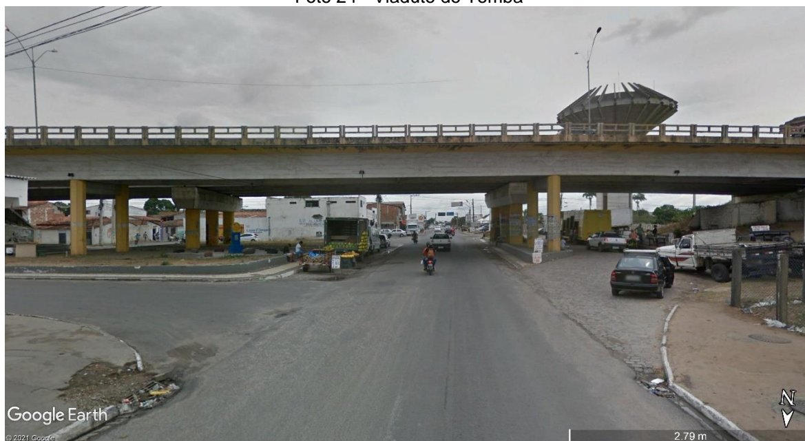
Foto 24 - Viaduto do Tomba
