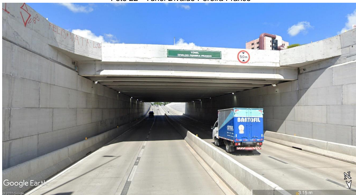
Foto 22 - Túnel Divaldo Pereira Franco
