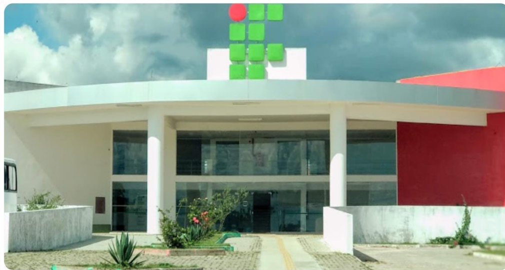
Figura 2 - Foto da fachada principal do Instituto Federal Baiano, campus Serrinha
