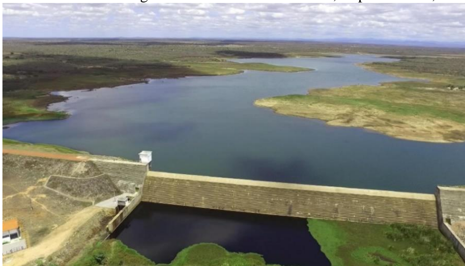
Foto 6: Área da barragem de Pedras Altas do Mirim, Capim Grosso, 2017
