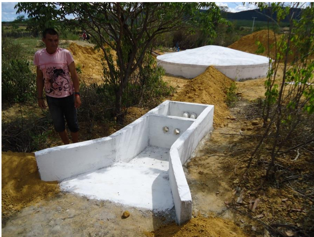
Figura 4 - Cisterna de enxurrada
