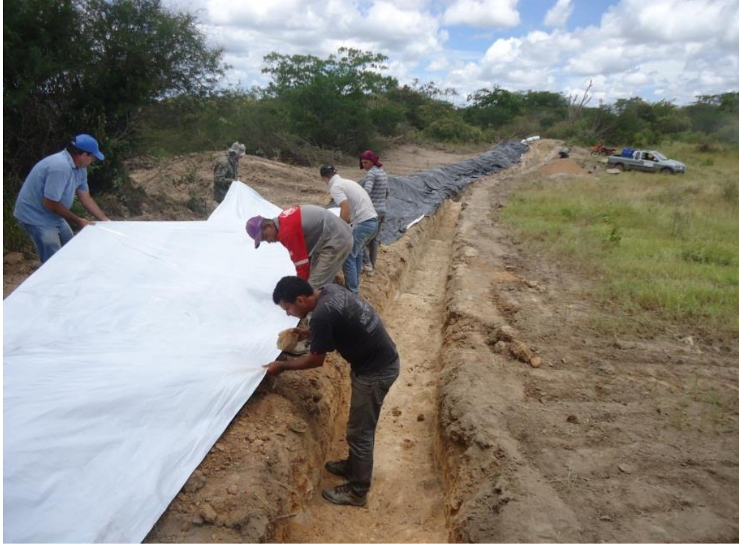
Figura 8 - Construção de barragem subterrânea
