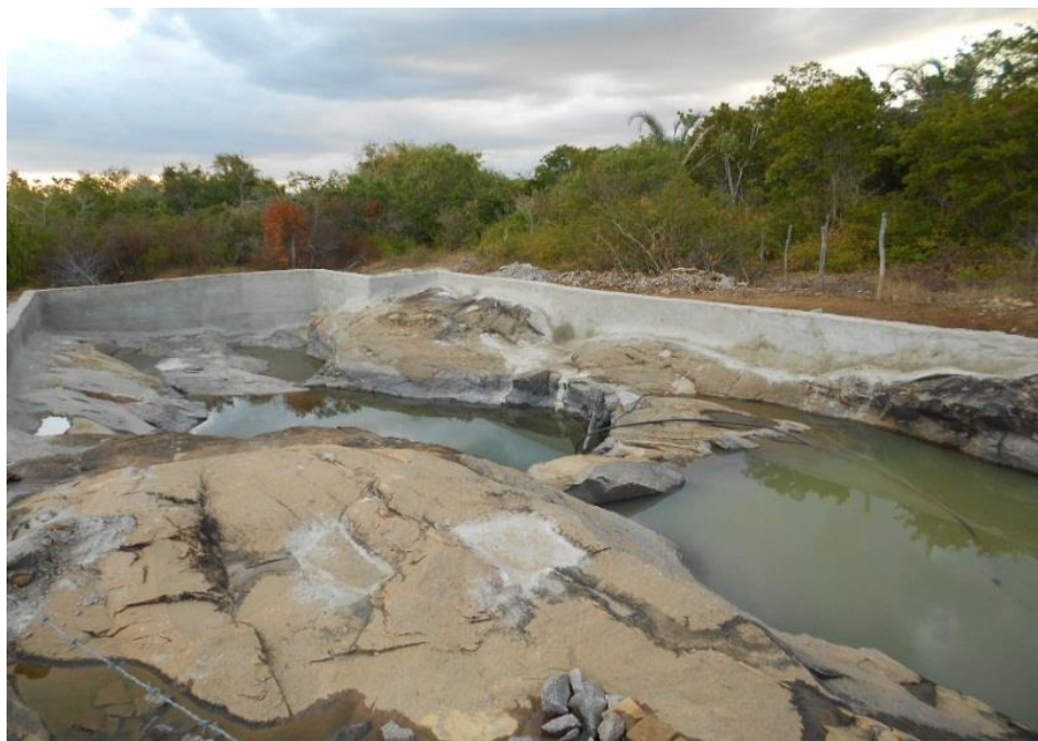
Figura 7 - Tanque de Pedra
