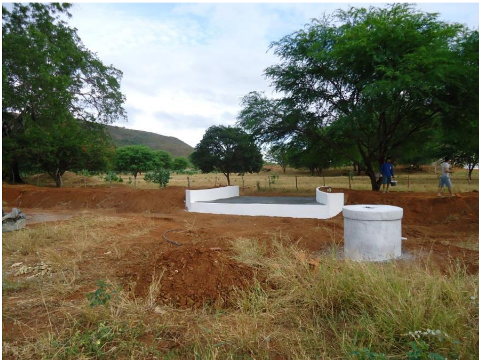
Figura 9 - Barragem subterrânea concluída
