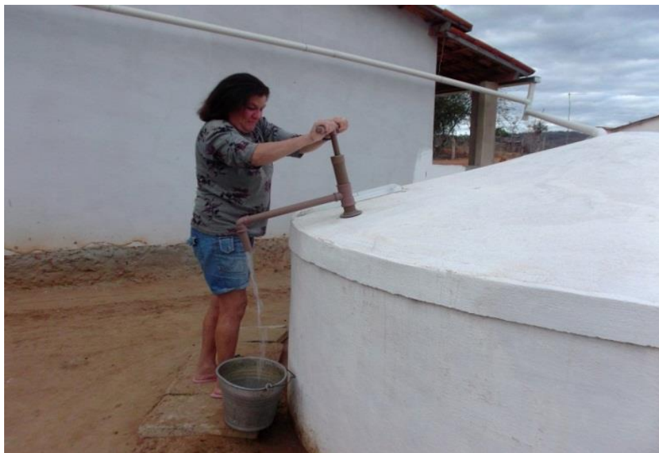
Figura 2 - Utilização da bomba manual para retirada de água da cisterna
