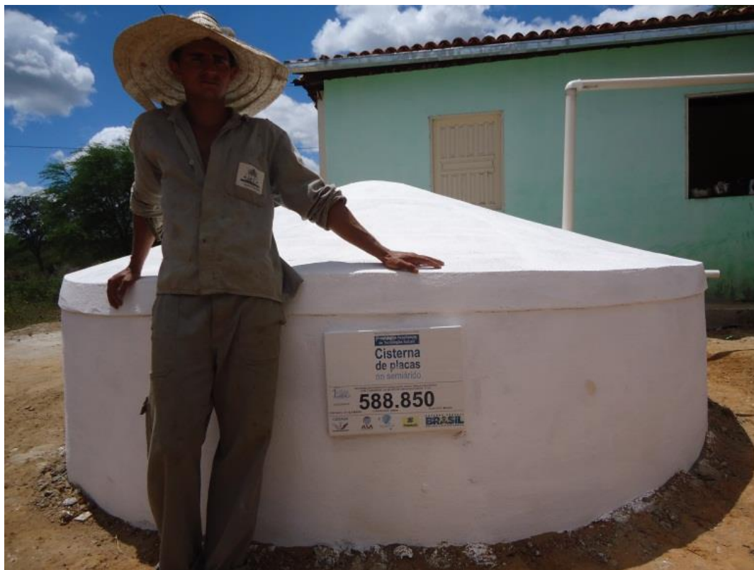
Figura 1 - Cisterna de placas de 16 mil litros do P1MC
