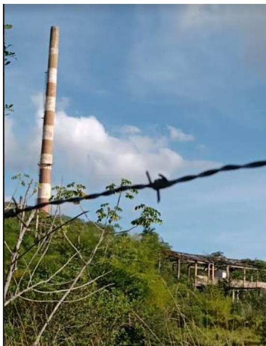
Vista da ruína da Cobrac.
