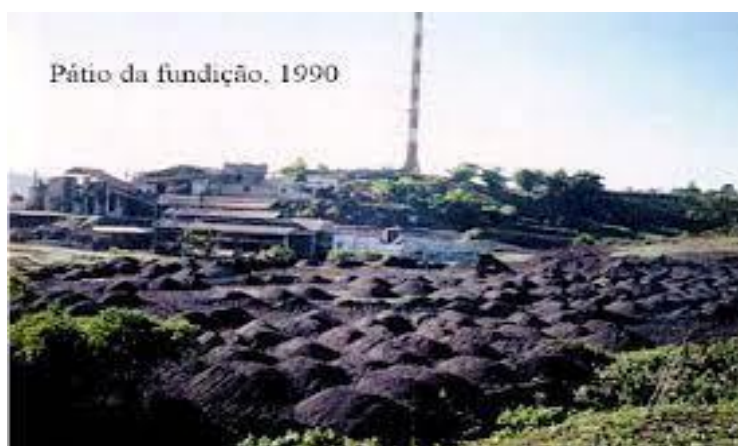
Figura 3: Área externa da COBRAC, ainda em seu funcionamento, onde a escória de chumbo era depositada ao ar livre.
