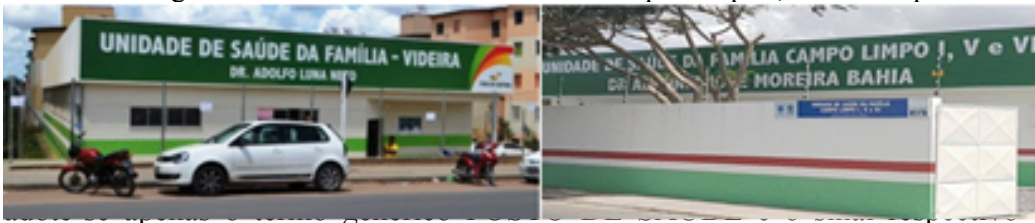
Figura 24 - Frente das USF Videira e Campo Limpo I, V e VI respectivamente
