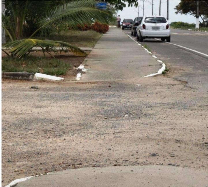
Figura 12 - Rota 1: segmento Reitoria - Biblioteca. Rampas de calçada para pedestre em degradação e sem conexão pavimentada.
