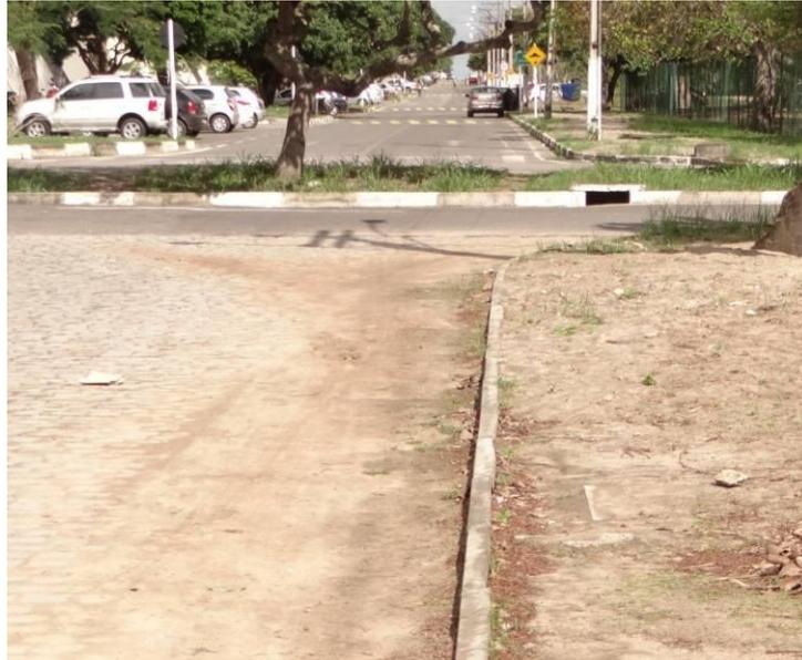
Figura 28 - Rota 5: segmento LABIO/CEB que apresenta ausência de pavimentação seguida por cruzamento com duas vias para automóveis com uma “ilhota” entre elas, sem que haja qualquer tipo de travessia facilitada, nem por faixas, nem por rebaixamento de calçada.
