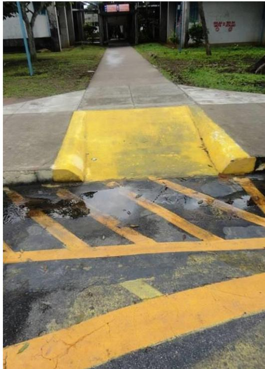
Figura 40 - Rota 6: faixa de sinalização de lombada à frente da rampa para acesso à Rota 3.
