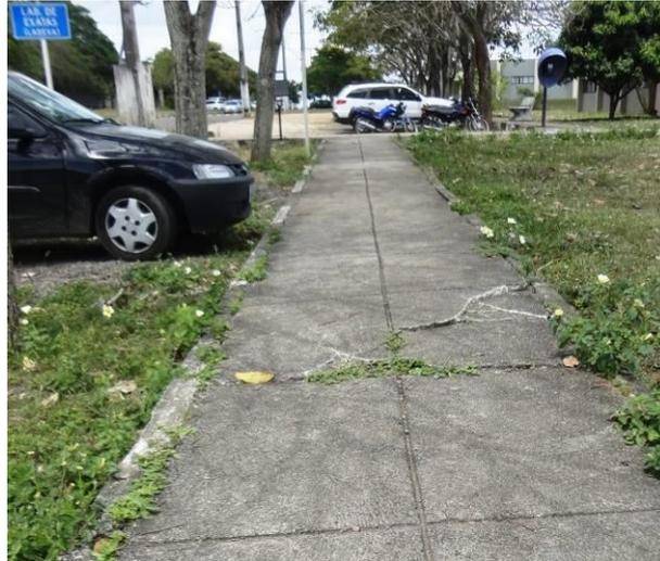
Figura 36 - Rota 5: calçada para pedestres em frente ao Labexa em estado de degradação.
