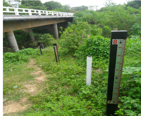
Figura 05. Atual ponte sobre ponto 3 e as régua de nível.
