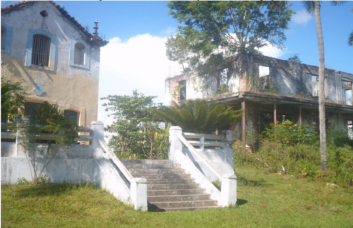
Figura 11 - Ruínas da Fábrica Opalma no Vale do Iguape
