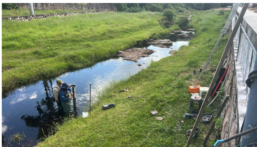
Figura 3 instalação régua nível Foto própria autoria /2026
