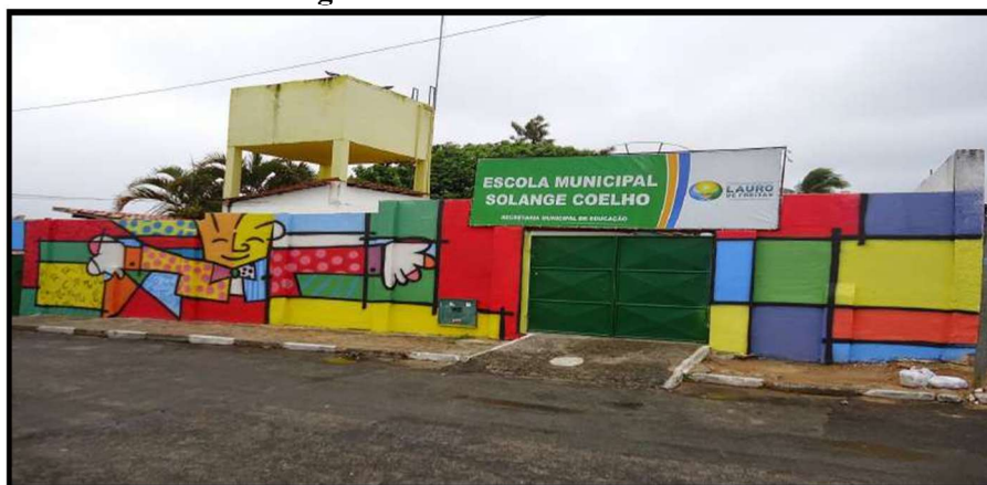
Figura 17 – Fachada da EMSC
