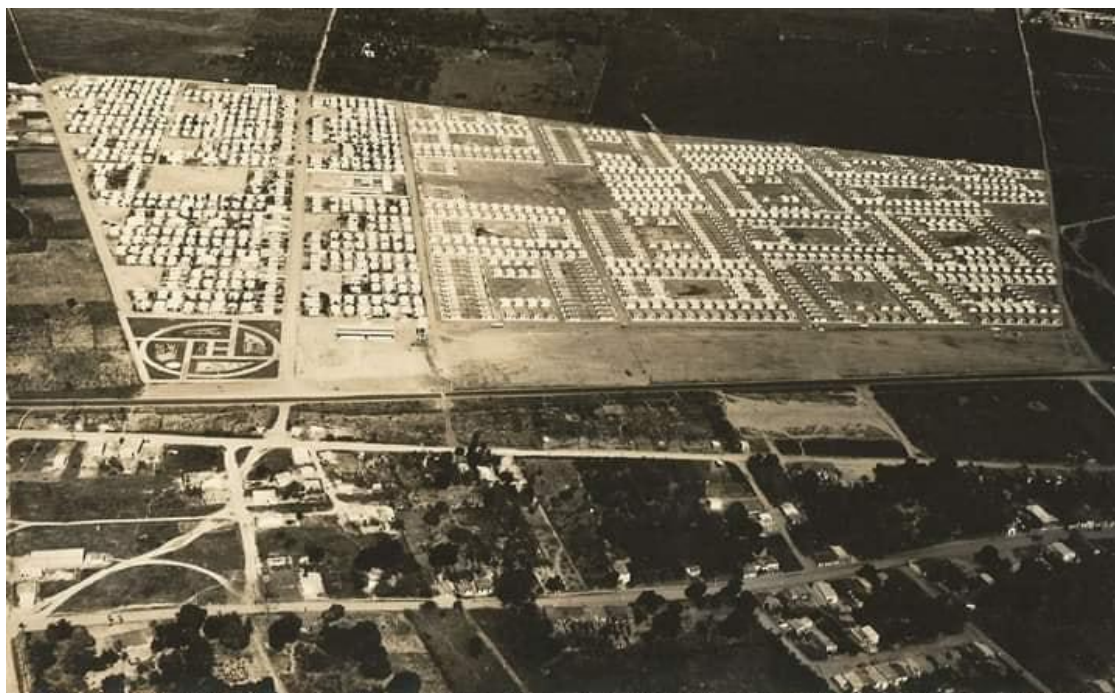
FOTO 3 - CONJUNTO FEIRA 1 (PARTE DA ATUAL CIDADE NOVA) NA DÉCADA DE 1960
