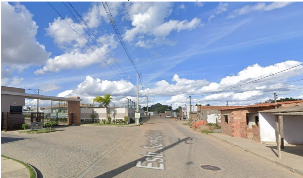
FOTO 8- FEIRA DE SANTANA: RUA SANTA QUITÉRIA, TRECHO DE ACESSO AO CONDOMÍNIO RAVENNA, BAIRRO PAPAGAIO, 2022
