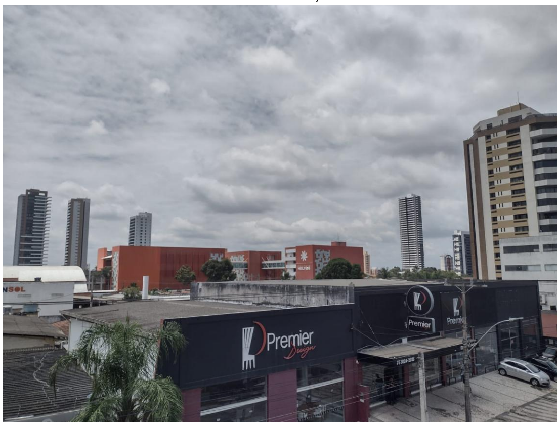
FOTO 4- FEIRA DE SANTANA: PRÉDIOS RESIDENCIAIS DE ALTO PADRÃO NO BAIRRO SANTA MÔNICA, 2024
