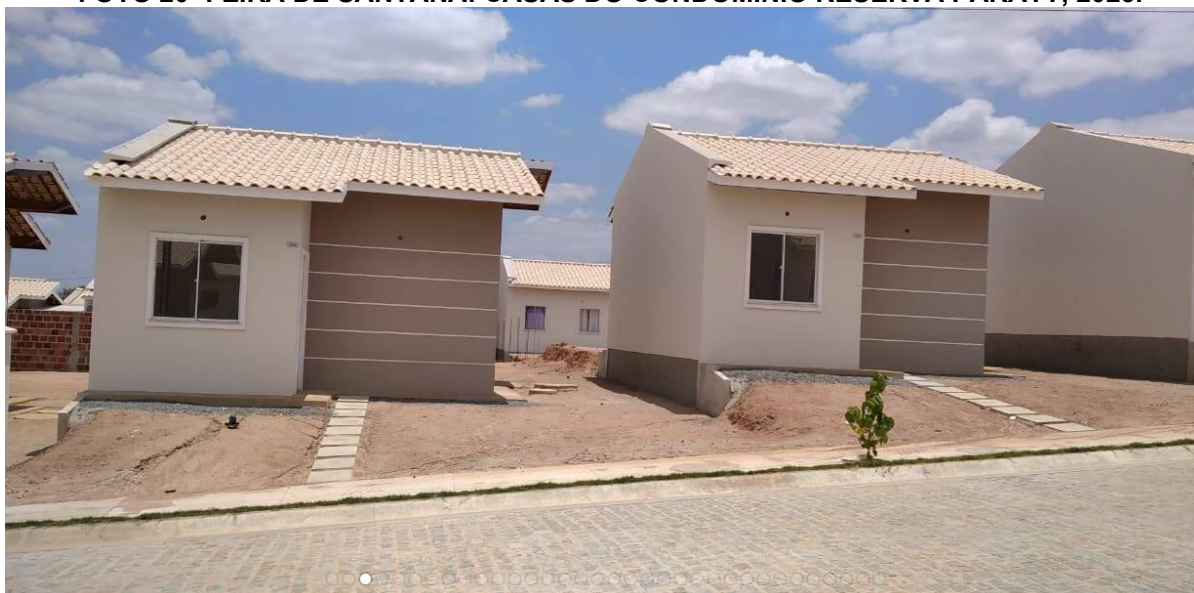
FOTO 20- FEIRA DE SANTANA: CASAS DO CONDOMÍNIO RESERVA PARATY, 2023.
