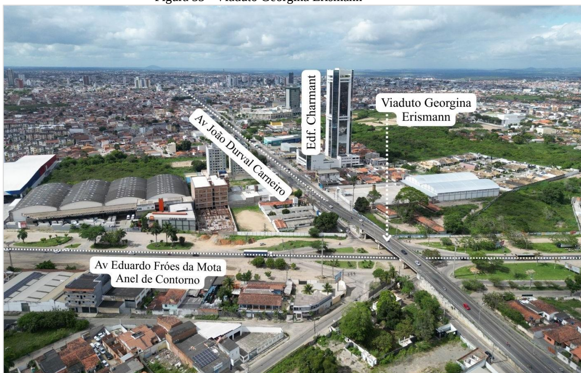
Figura 33 - Viaduto Georgina Erismann
