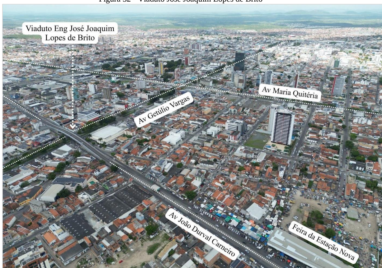
Figura 32 - Viaduto José Joaquim Lopes de Brito
