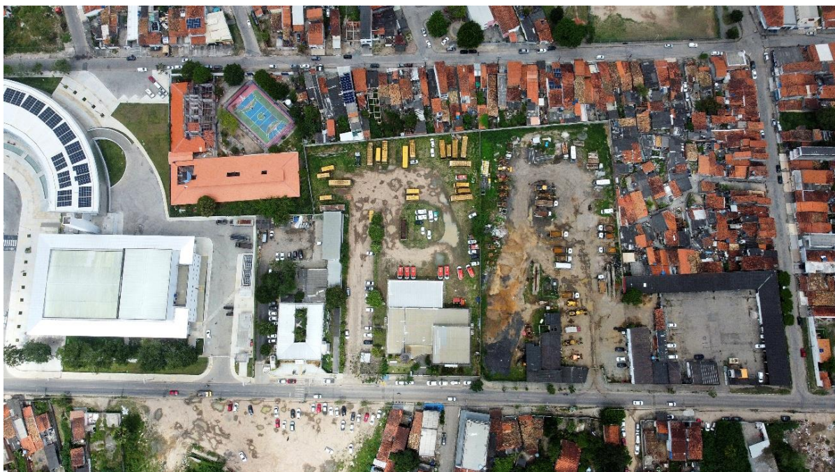
Figura 24 - Vista aérea do Museu Parque do Saber e seu entorno
