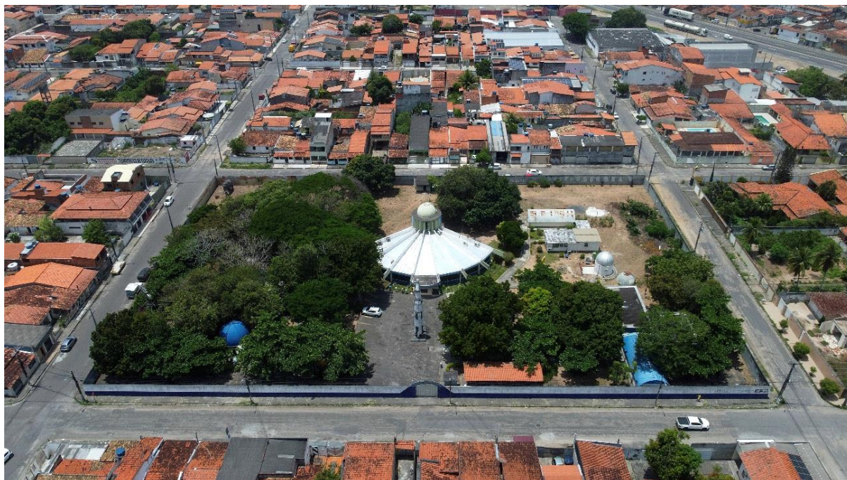
Figura 17 - Visualização aérea do Museu Antares e trecho da Rodovia BR-116
