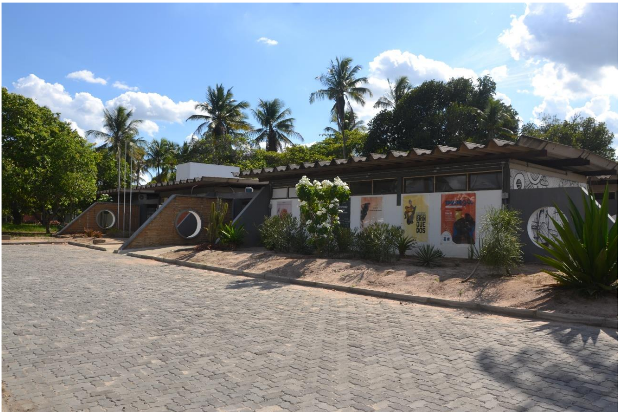
Figura 15 - Fachada da Casa do Sertão
