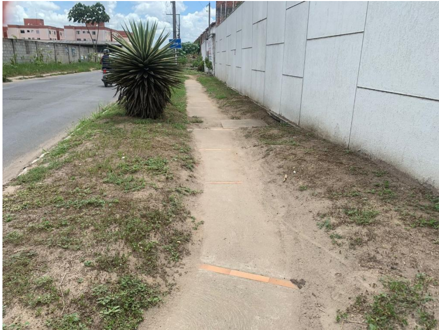
Figura 26: Calçada existente lindeira ao condomínio Residencial Horto Florestal
