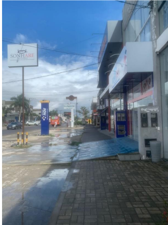
Figura 30: Calçada em frente a estabelecimentos comerciais da avenida
