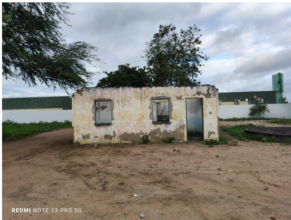
Figura 2: Ruínas da Casa que funcionou a escola Vasco da Gama, localizada em frente ao prédio atual da Escola Municipal Quilombola Luiz Pereira dos Santos, ao lado da sede da AQCOMAC
