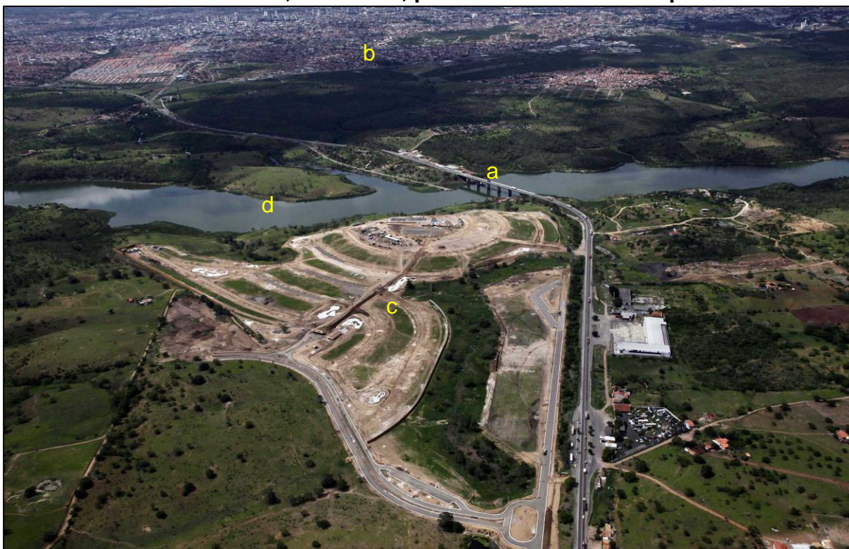
Foto 25 – BR-116 Sul, Rio Bahia, ponte sobre o Rio Jacuípe em 2013
