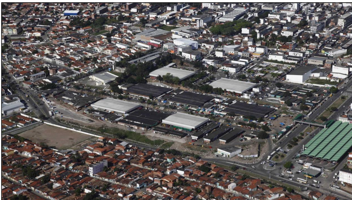
Foto 11 – Centro de Abastecimento de Feira de Santana em 2015
