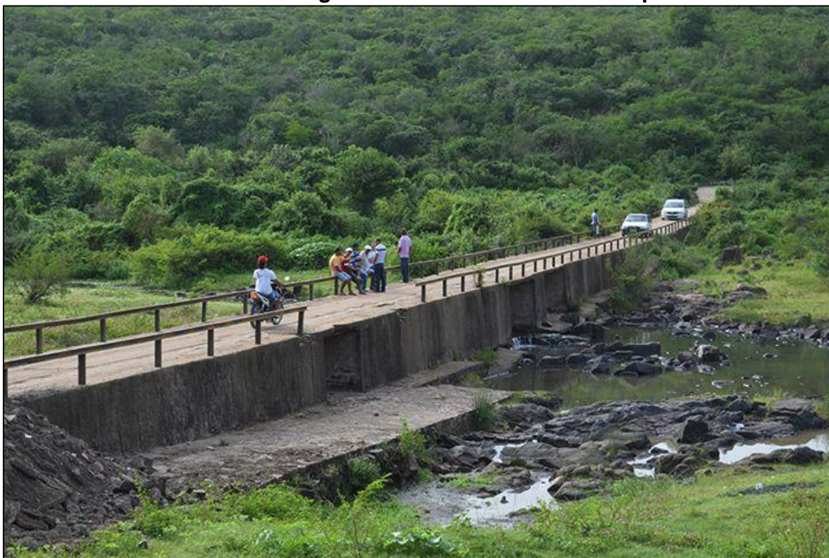
Foto 5 – Passagem molhada sobre o rio Jacuípe
