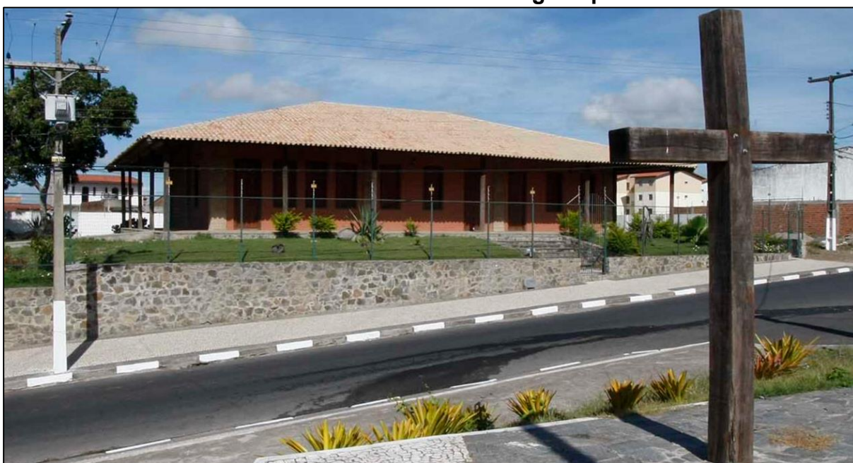
Foto 3 – Casarão Fazenda Olhos d' Água após reforma
