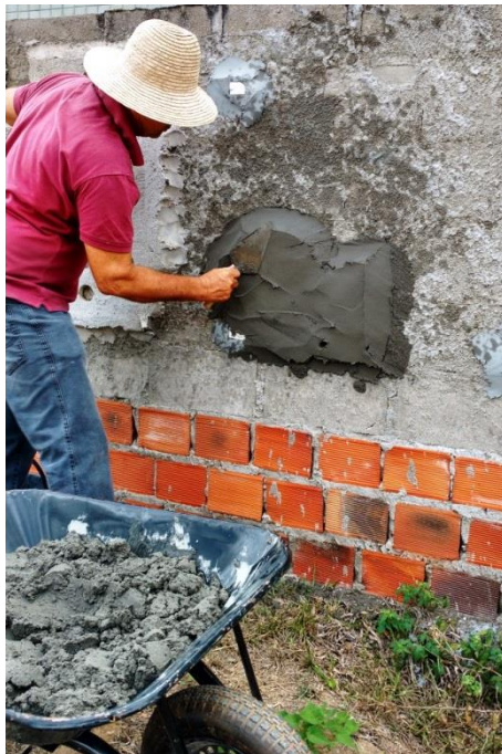
Figura 37 - Aplicação da argamassa para ensaio de aderência
