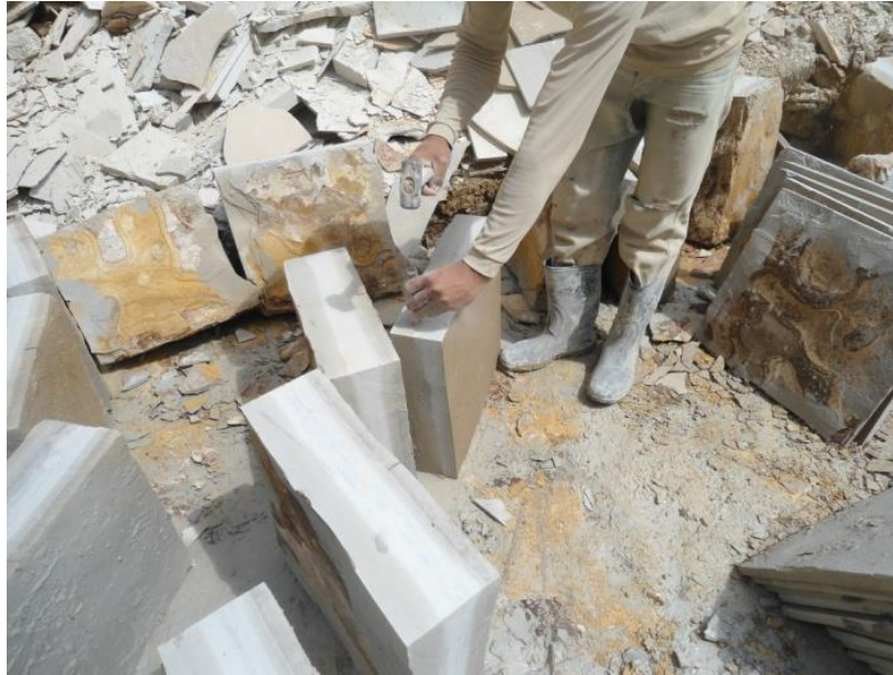
Figura 6 - Aspecto do deslocamento manual das lajotas (Fonte: BASTOS, 2014).
