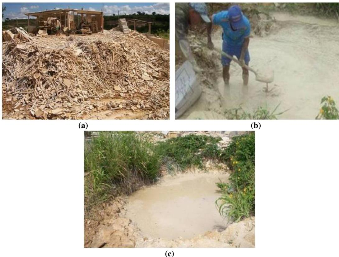
**Figura 31** Deposição dos resíduos de pedra Cariri: (a) Aspecto das pilhas de RPC (Fonte: SUASSUNA *et al.*, 2012); (b) Aspecto da deposição do RSPC (Fonte: BASTOS, 2014); (c) Aspecto da lagoa de lama de RSPC (Fonte: BASTOS, 2014)
