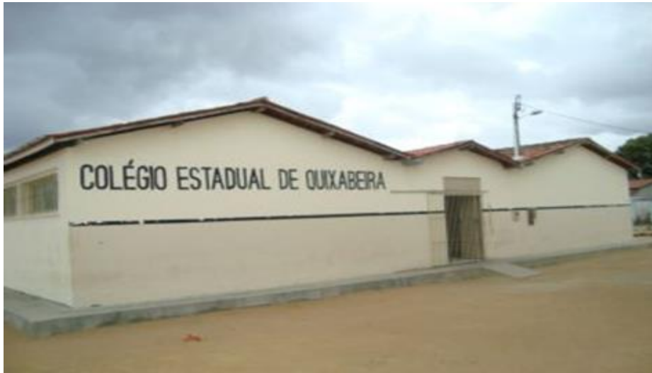
Fotografia 2: Antigo prédio do Colégio Estadual de Quixabeira.
