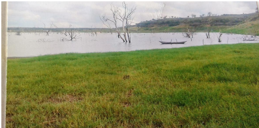
Fotografia 15. Barragem de São José do Jacuípe.
