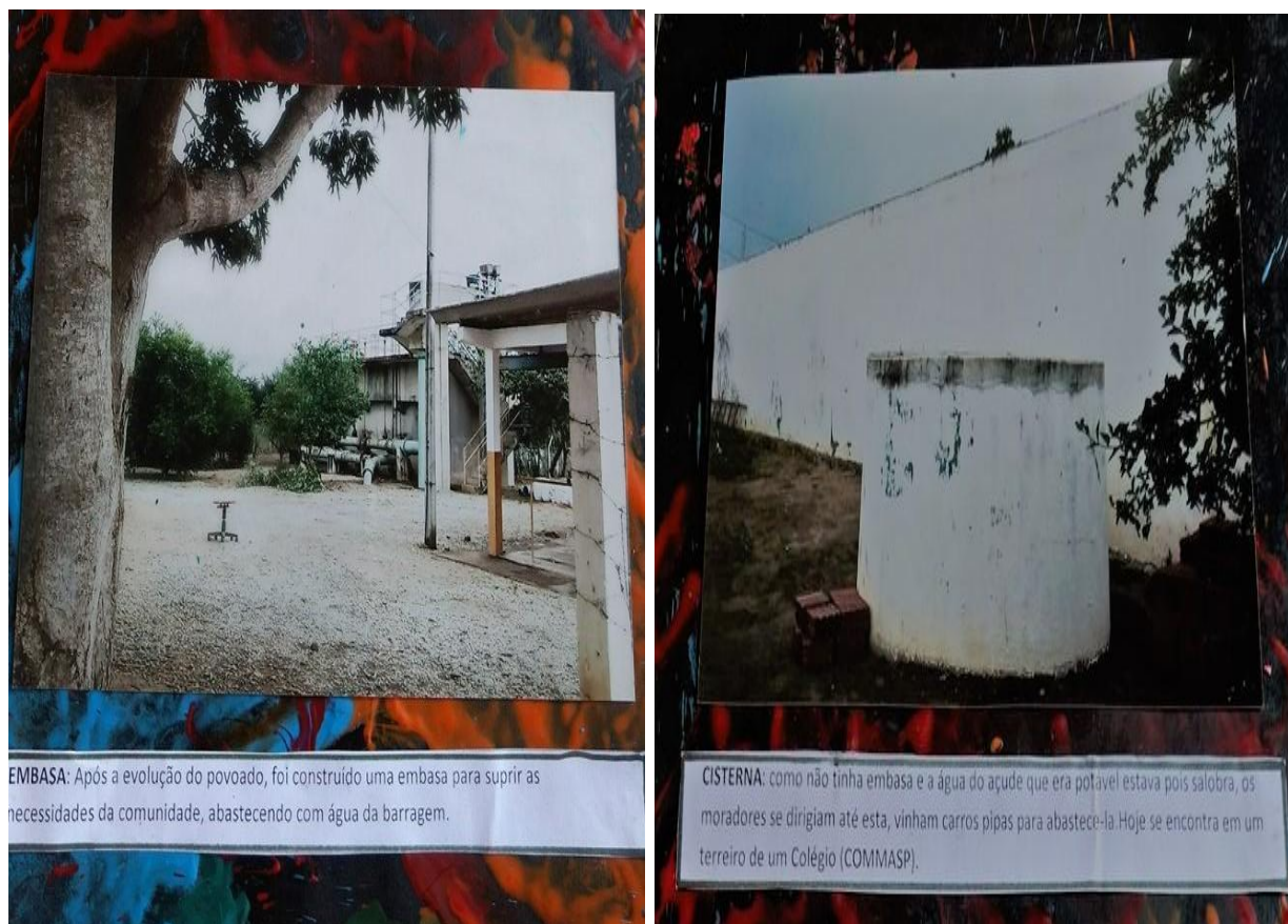
Fotografia 17. Cisterna pública e instalação da Embasa.
