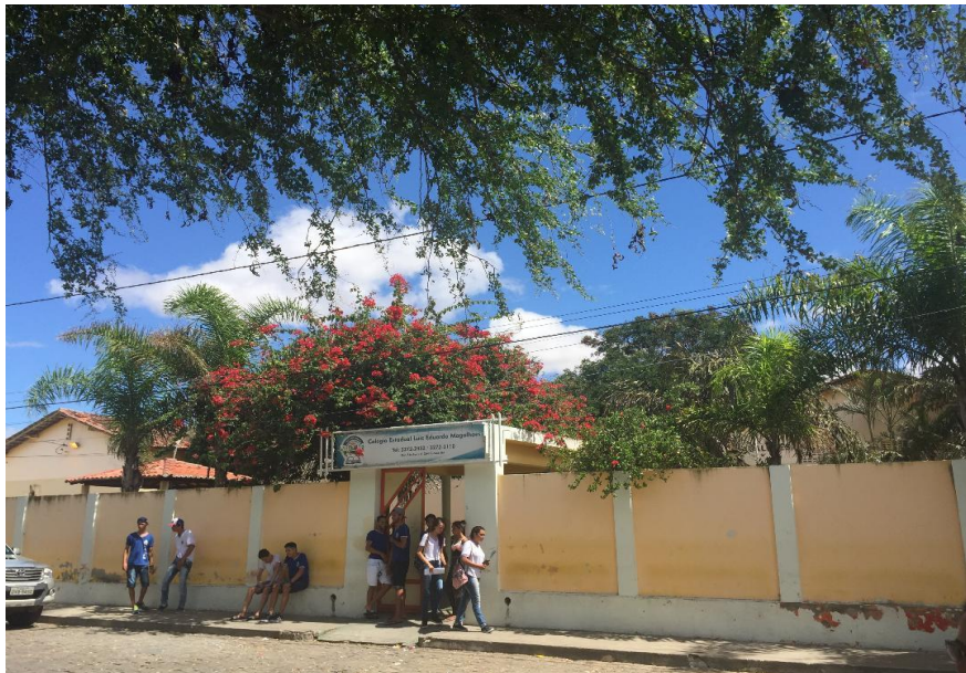
FIGURA 02 – Fachada do Colégio Estadual Luís Eduardo Magalhães. FONTE: Arquivo pessoal da autora, 2018.
