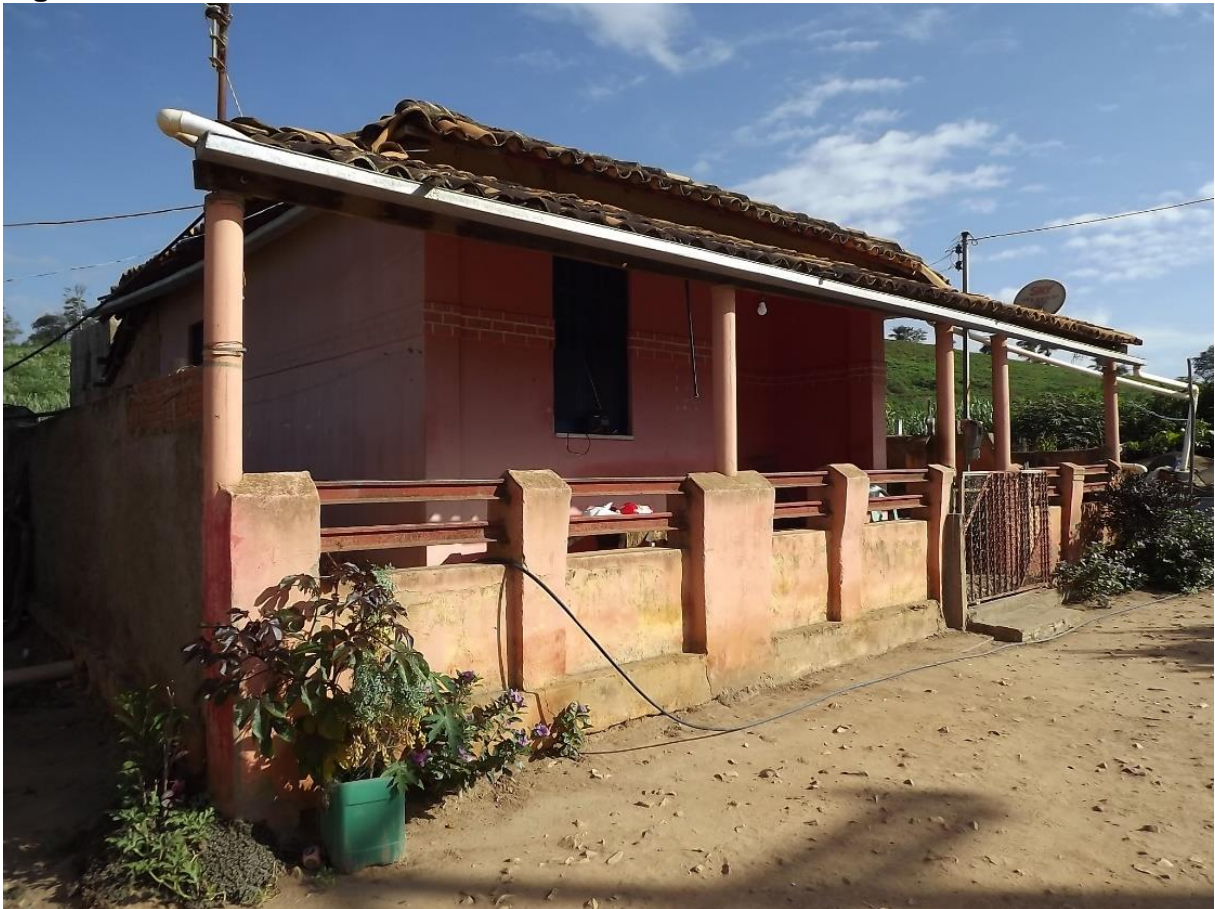
Figura 6 - Residência na localidade de Bom Jardim, Caem
