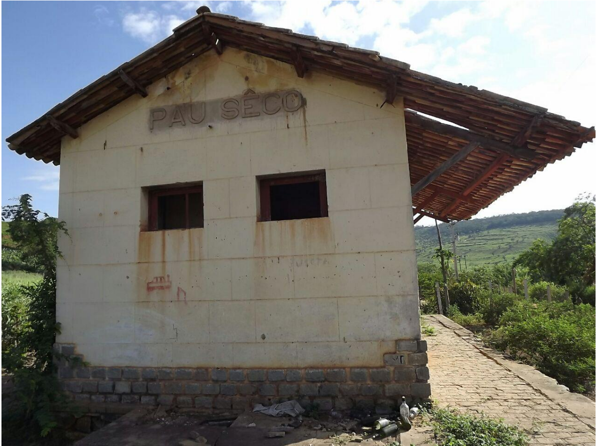
Figura 5 - Estação de trem Pau Seco
