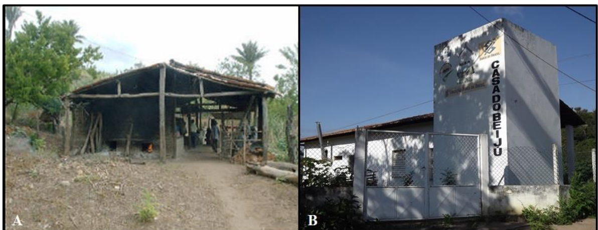
Figura 20 - Locais de produção do beiju da associação AquiBom. A - Antes da construção da indústria; B - Após a construção da Indústria
