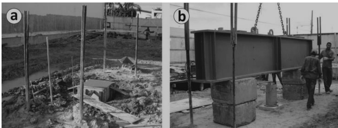
Figura 9 Sistema montado para o ensaio de prova de carga estática, a) Arranques das estacas de reação e bloco de coroamento e b) Montagem do sistema (Fonte: Soares et al. , 2014).
