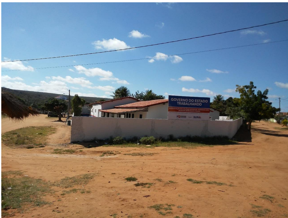
Figura 1. Escola Kaimbé, situada na entrada da vila na estrada que sai para a cidade de Euclides da Cunha. Vê-se uma placa de obra do Governo do Estado; trata-se de uma reforma que foi feita no ano de 2018.(Acervo particular do pesquisador, maio/2018)
