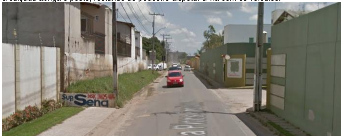
Figura 6 – Trecho do início da Av. Artêmia Pires. A calçada demonstra completo descaso com o pedestre, compondo apenas a fachada do ERF (à direita), do outro lado da via (à esquerda), a calçada abriga o poste, restando ao pedestre disputar a via com os veículos.
