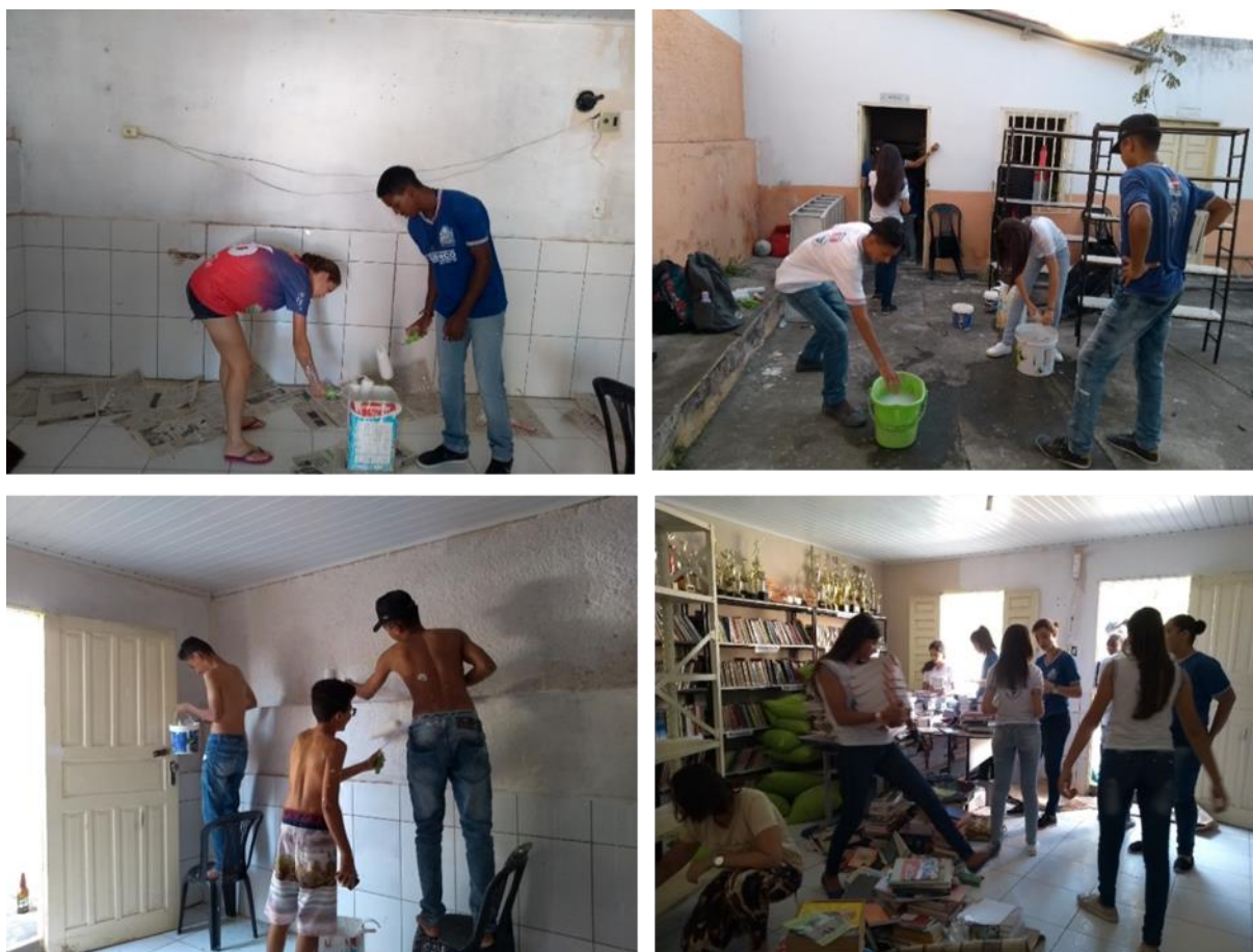
Figura 44 - Reforma da biblioteca
