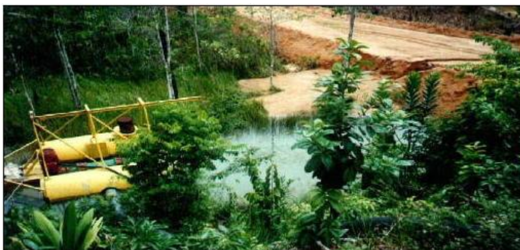
Figura 7 - Barragem da EMBASA no Rio dos Mangues. Fonte: Tôsto et al. (2003).
