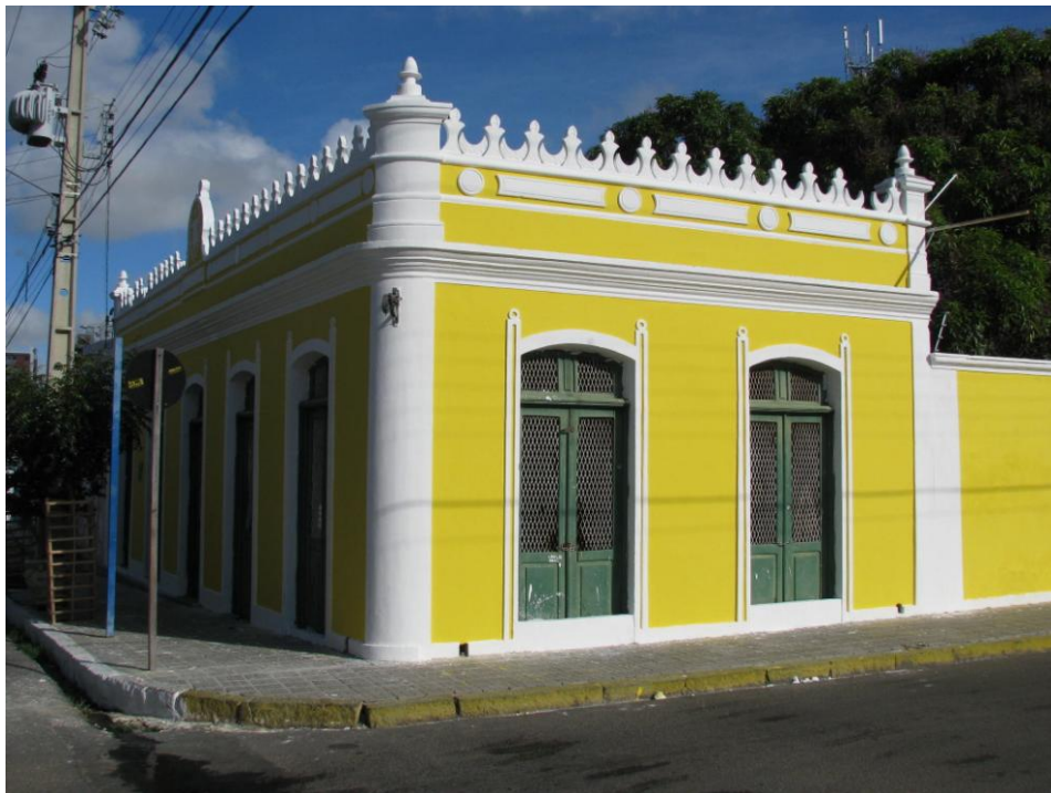
Primeiro açougue municipal em Petrolina com simetria na fachada
