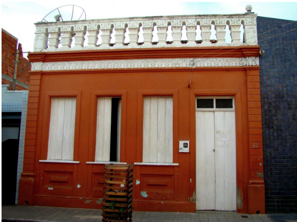
Exemplo de uma fachada com platibanda vazada e bordada na cidade de Juazeiro/BA.
