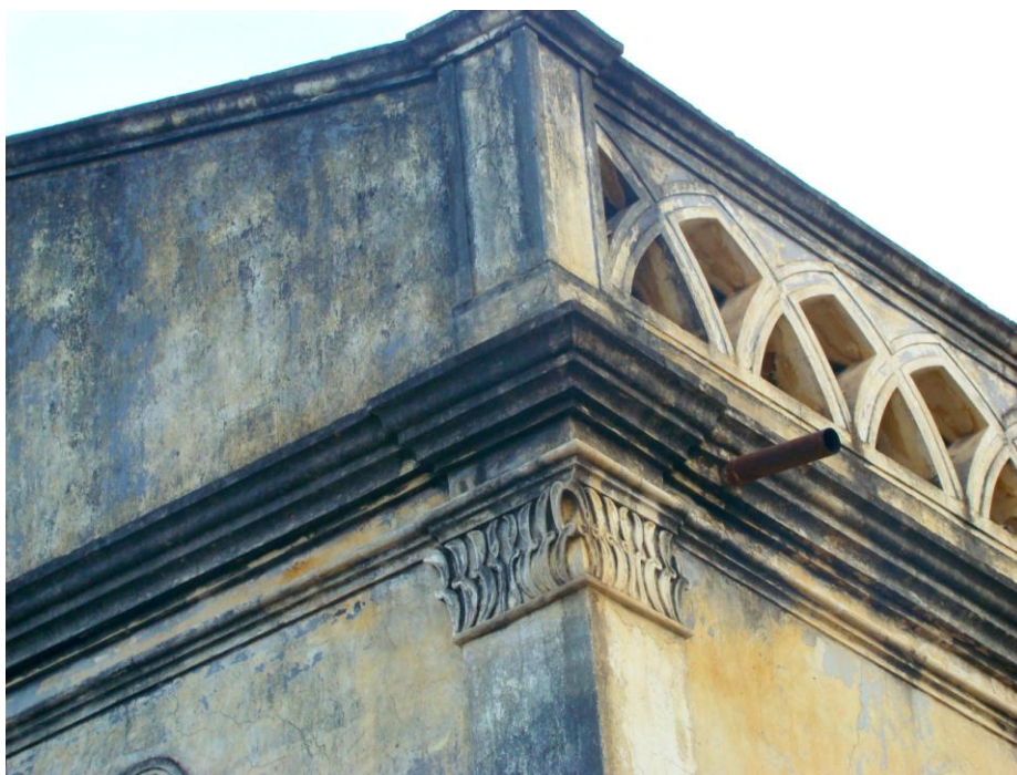
Exemplo de platibanda vazada na cidade de Juazeiro/BA.
