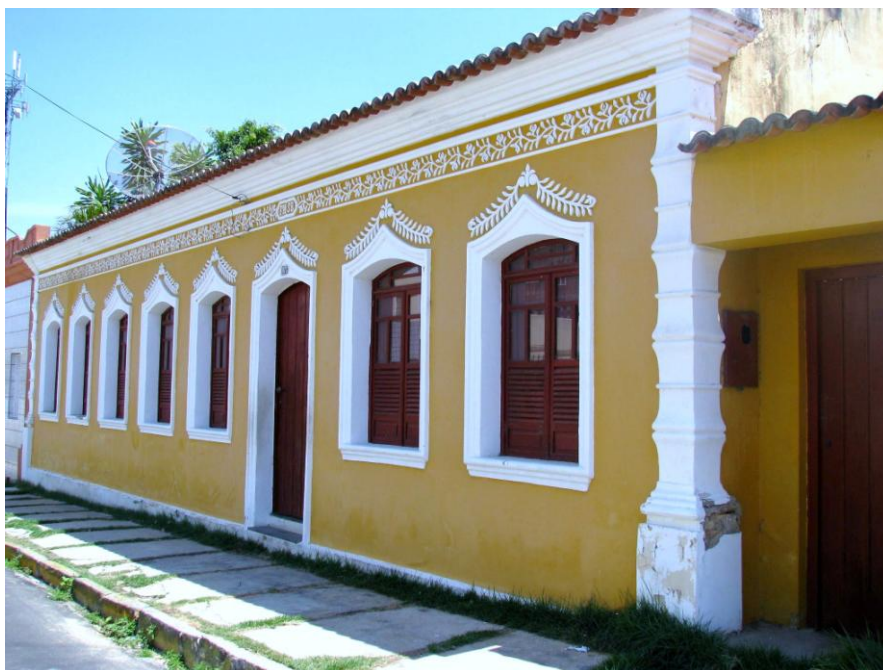
Casa em Petrolina de Beira bica (telhas expostas) bordada sem platibanda
