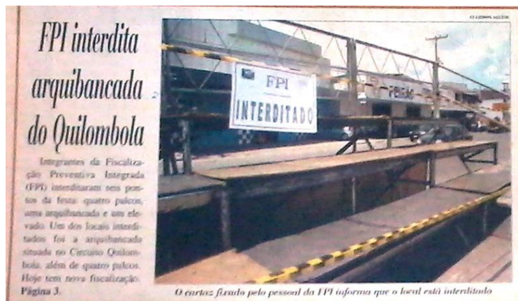
Figura 35 - Arquibancada interditada no Espaço Quilombola.
